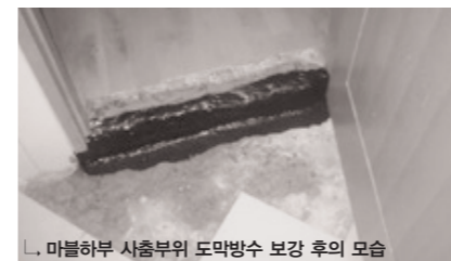
↳ 마블하부 사춤부위 도막방수 보강 후의 모습
